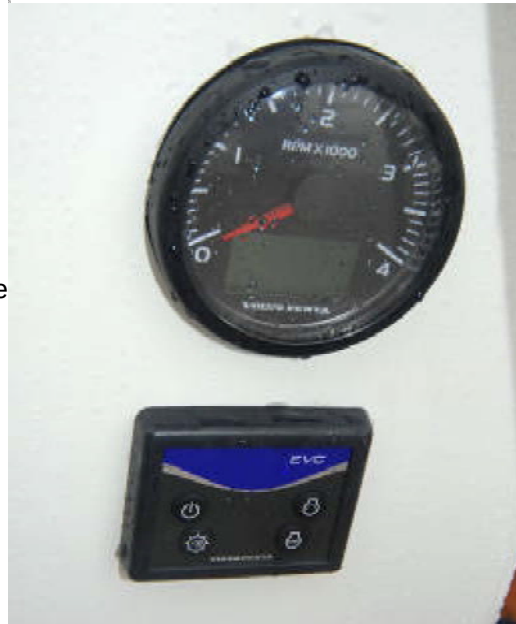
Det er Volvoer med EVC hvor du kan starte uten nøkkel som har problemer.
