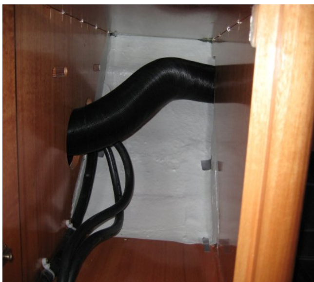
Gennemføring gennem skab under kortbord, der var ikke boret et hul i den ene side men der var åben så man lige kunne presse slangen igennem, her var det dejligt med en der kunne skubbe i den ene ende og den anden trække i skabet.
